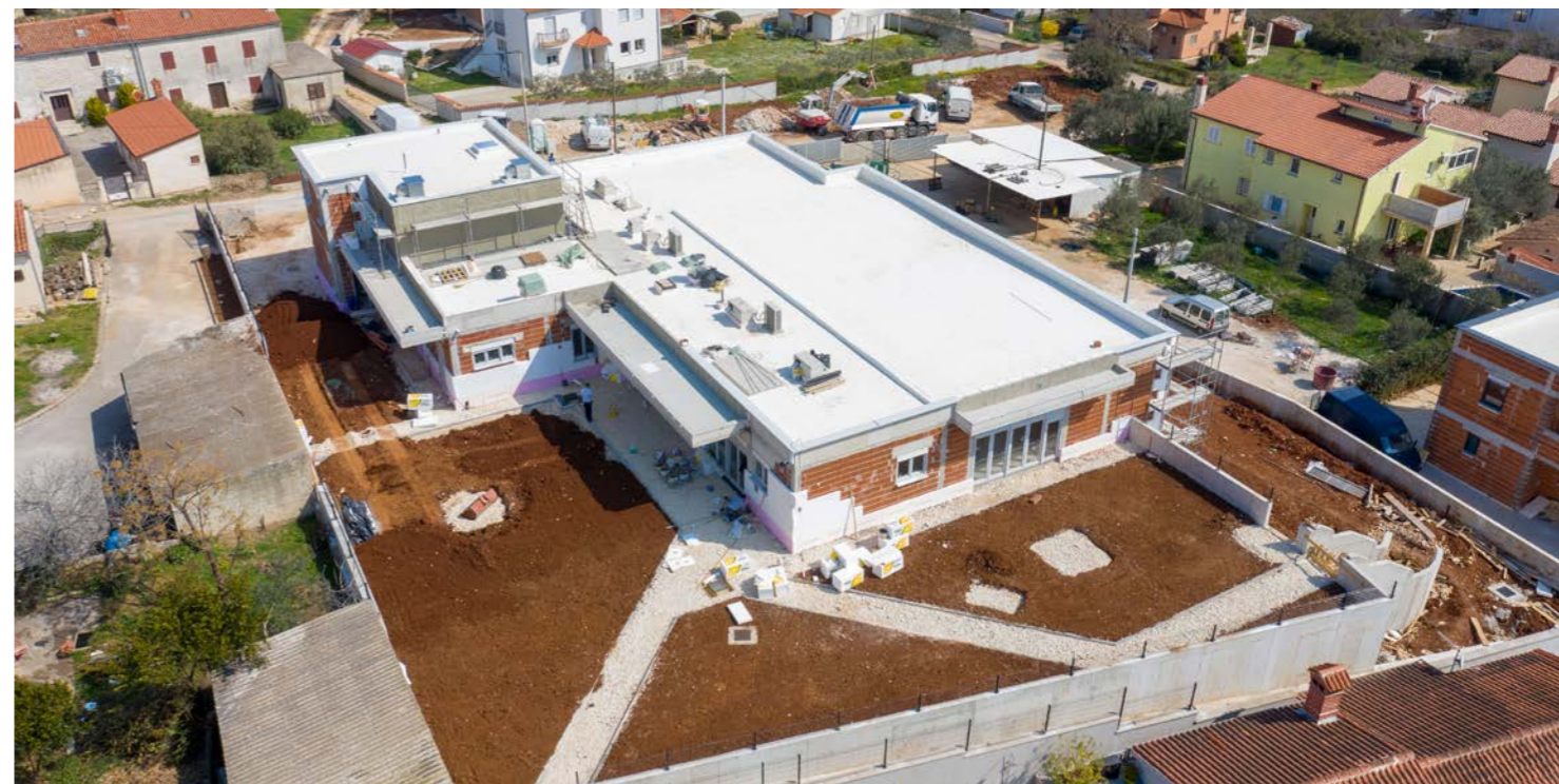
Izgradnja vrtića Ližnjan
