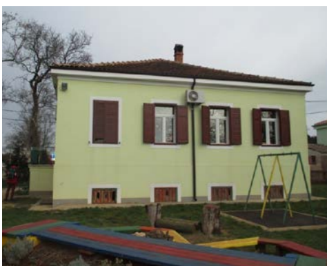
Obnovljena zgrada vrtića u Šišanu
