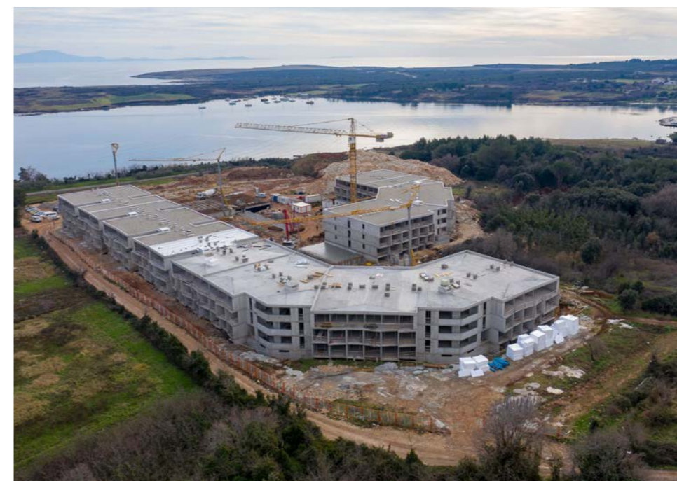
Gradilište velikog turističkog kompleksa u Ližnjanu
